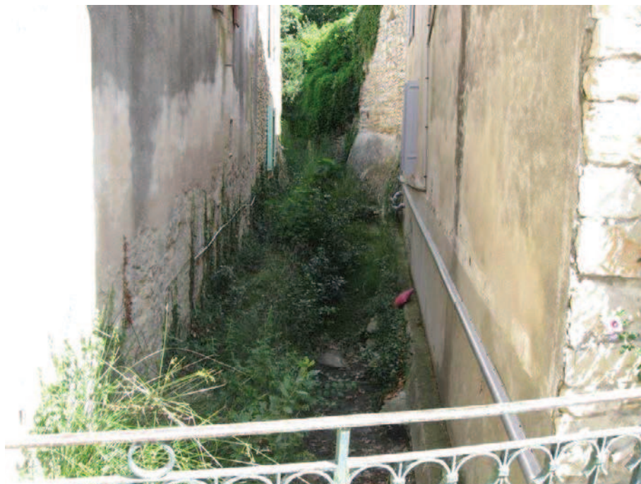
Figure 6 : Endiguement par des murs d’habitations dans la traversée de Saint-Côme
