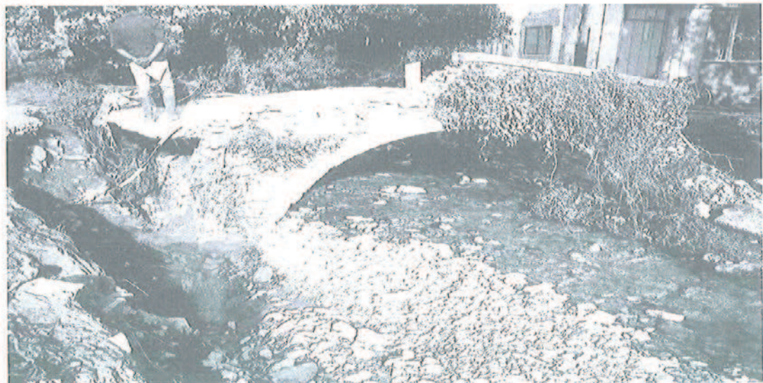
Le pont du moulin de Chassatn.
