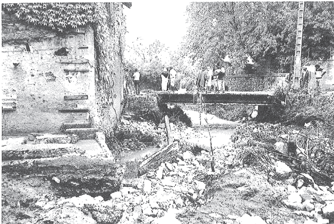
Ce qu'il reste du pont.
