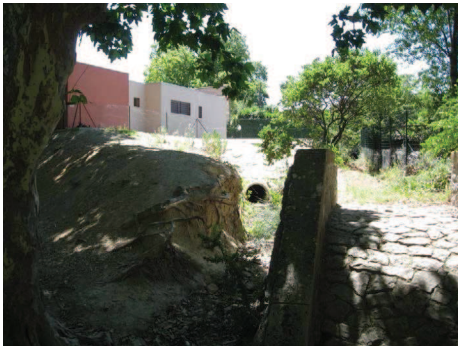
Figure 5 : Remblai et aménagement hydraulique à Langlade
