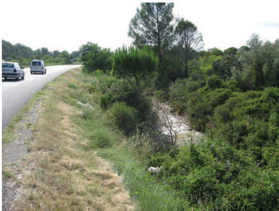
Figure 3 : Remblai routier longé par le Rianse.
